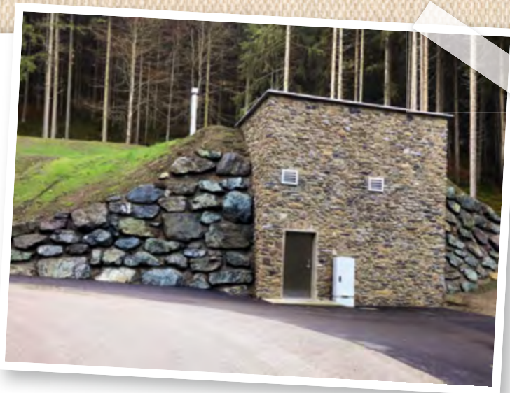
WVA Glödnitz – Neubau Hochbehälter
