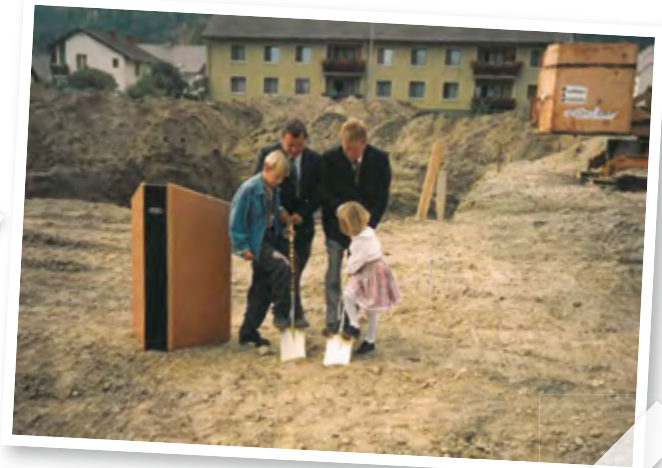
Spatenstich für den Bau des Gemeindehauses
